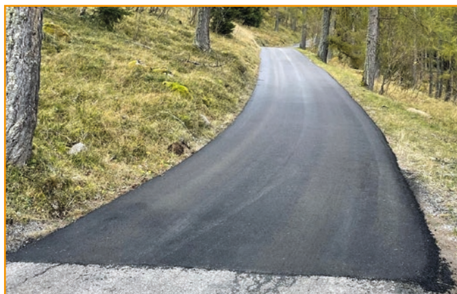
Richtn der pourn pet en asfalto ver a stuck va Gamoa'be kan Kaserbisen
